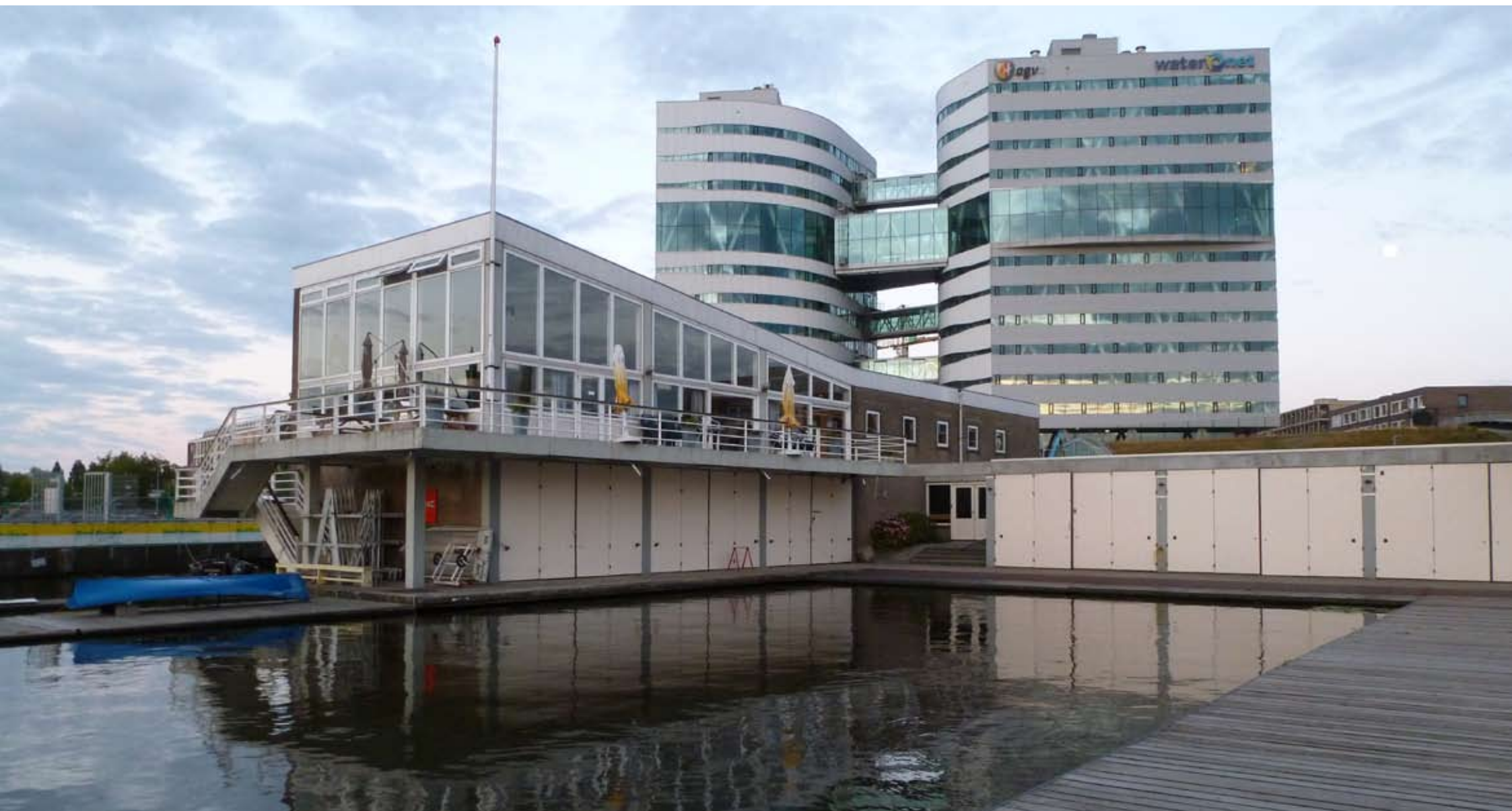
HUIDIGE AANZICHT VANAF DE WATERZIJDE
