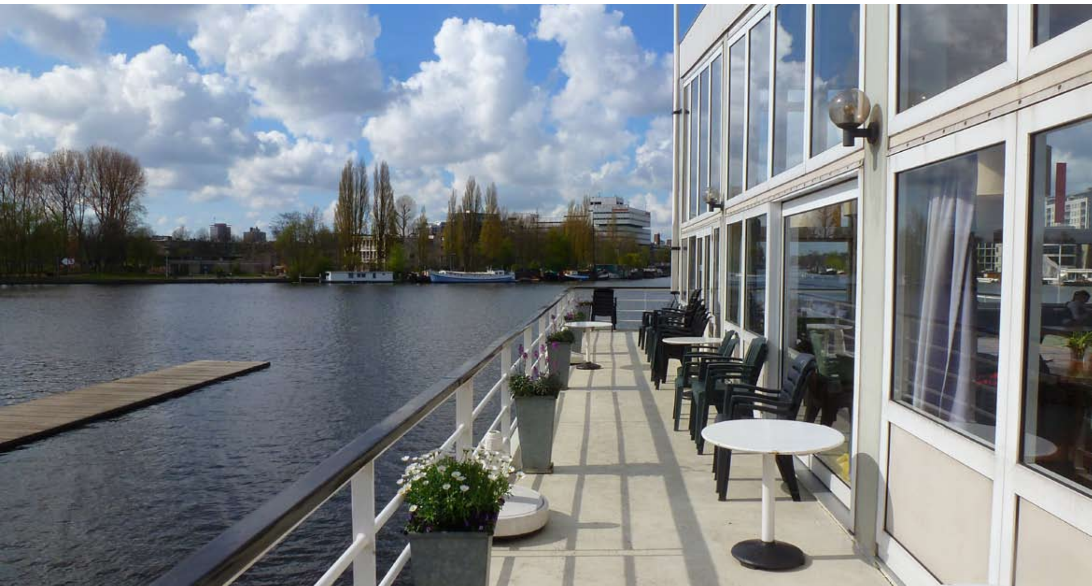
HET TERRAS EN HUIDIGE KUNSTSTOF GEVEL MET ENKEL GLAS
